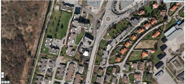
2011 Ny rundkjøring i krysset Madlaveien - Madlakrossen, nye leilighetsbygg nord for tomten langs Madlaveien. Søndre hus på tomten er revet. Nytt bygg er i ferd med å bygges.
