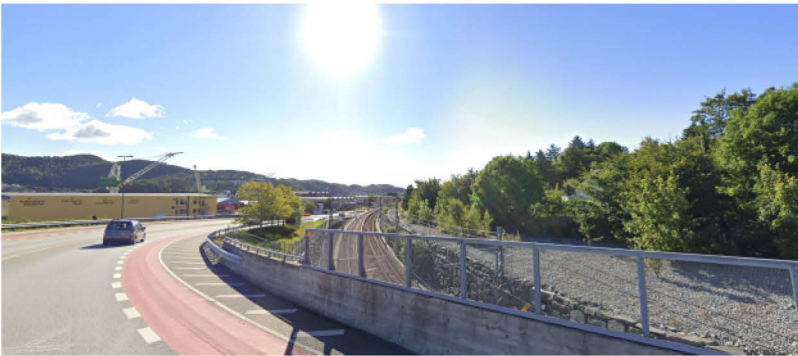
Strandgata sett fra nord. Jernbanen krysser under gateløpet.
