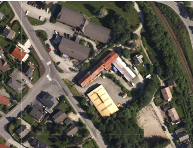
2006 Området ned mot jernbanen er grønnere og tettere. Trærne på oppsiden av tomten langs Roald Amundsens gate er høyere og tettere.
