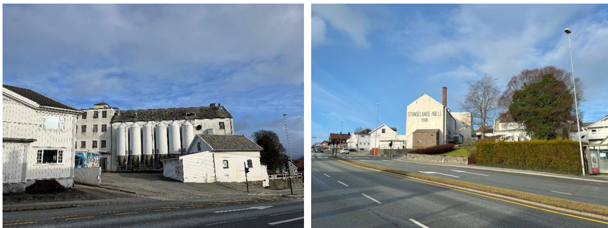
Figur 2 Stangeland Mølle hhv. fra nordvest og fra sørvest Oalsgata. De to siloene som stod nær Oalsgata er nå revet.
